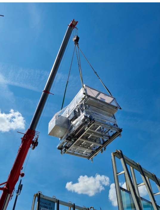
Schweres Gerät für ein großes High-Purity-System: Insgesamt wurden über 33 t Anlagenkomponenten in 16 Transporteinheiten in das erste und zweite Untergeschoss des Trumpf-Neubaus in Ditzingen eingebracht.
