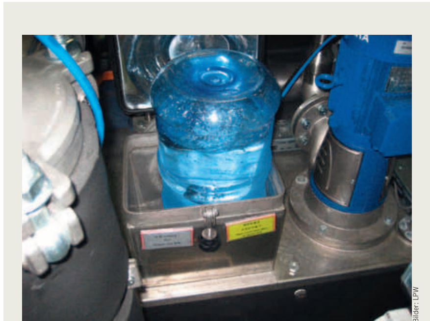
Hier musste ein deutscher LPW-Monteur in Asien improvisieren: Da im Produktionsbetrieb noch keine Wasseranschlüsse existierten, befüllte er die Anlage zum Testlauf mit 600 Litern Wasser aus 30 Getränkespenderkanistern.
