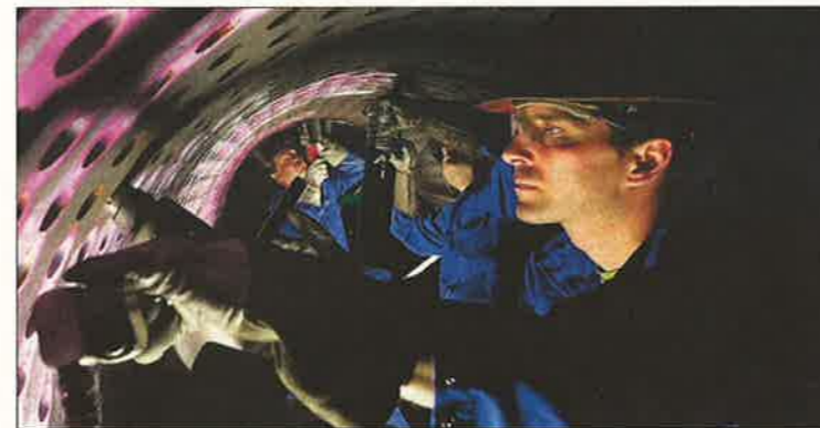
Instandsetzung eines Dampfkessels.
