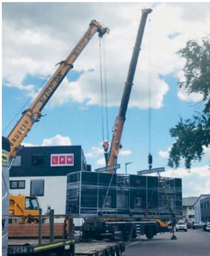
Aufgrund der enormen Größe musste die Anlage in fünf Teillieferungen verladen und per Schwertransport nach Ditzingen gebracht werden.
