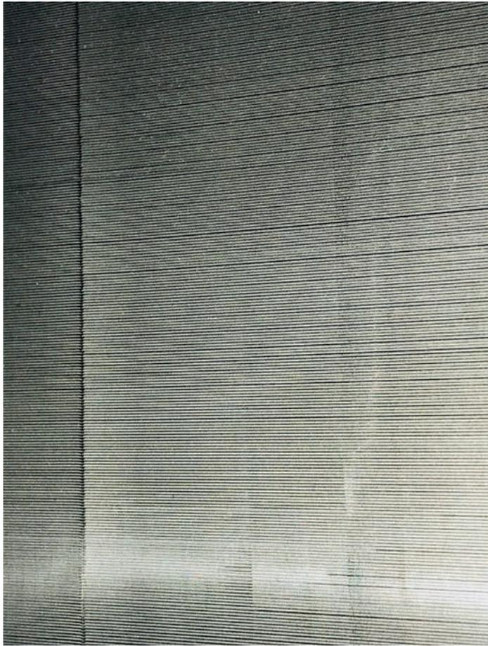
Lamellenstrukturen, wie beispielsweise bei Kühlelementen, stellen bedingt durch ihre Kapillarstrukturen hohe Anforderungen an die Reinigungstechnik. Ist ein gezielter Oberflächenangriff erforderlich, scheiden lösemittelbasierte Systeme aus.
