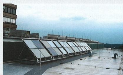
Die 30 Solarkollektoren auf dem Dach des Vaillant-Firmensitzes in Remscheid unterstützen die Heißwasserbereitung
