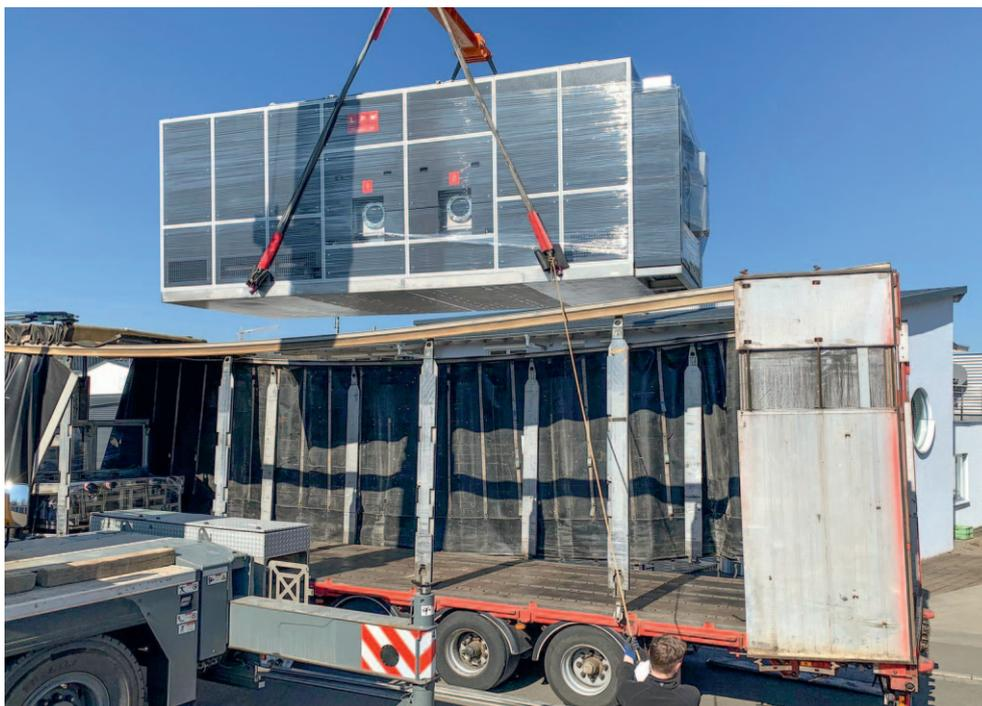
**Bild 5.** Gerade die Standardbaureihe PowerJet Ultra kann nach der Inbetriebnahme und Testphase ohne große Montagearbeiten vor Ort eingebracht und integriert werden
