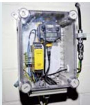
Das DX80-Gateway verarbeitet die Funksignale und leitet sie per Modbus-RTU an die Warte vor Ort und die zentrale Leitwarte weiter
