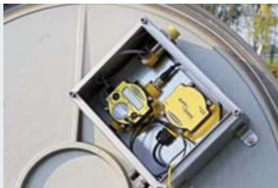
Die IP67-Komponenten der DX80-Anlage samt Sensor sind in einem Schaltkasten installiert
