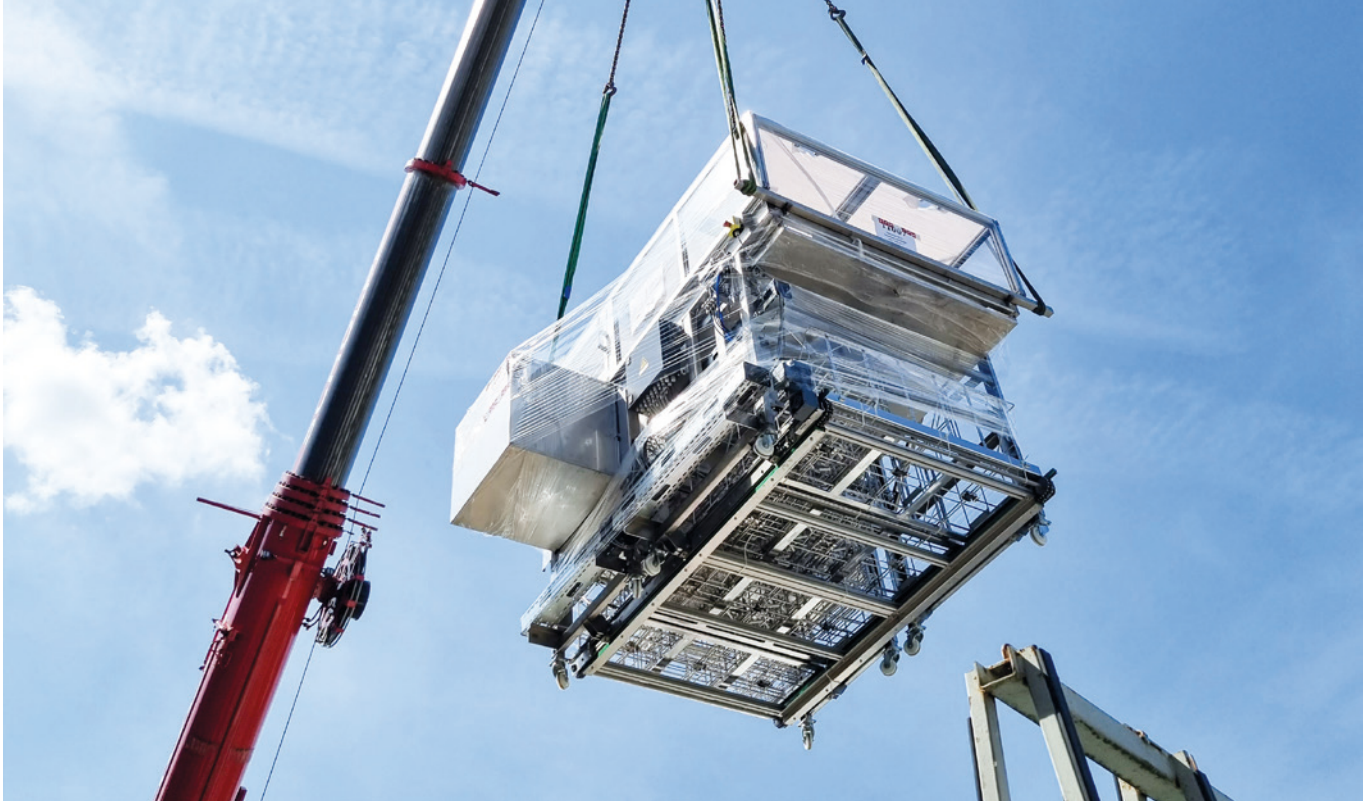
Schweres Gerät für eine großes High-Purity-System: Insgesamt wurden über 33 Tonnen Anlagenkomponenten in 16 Transporteinheiten in das erste und zweite Untergeschoss des Trumpf-Neubaus in Ditzingen eingebracht. ©LPW
